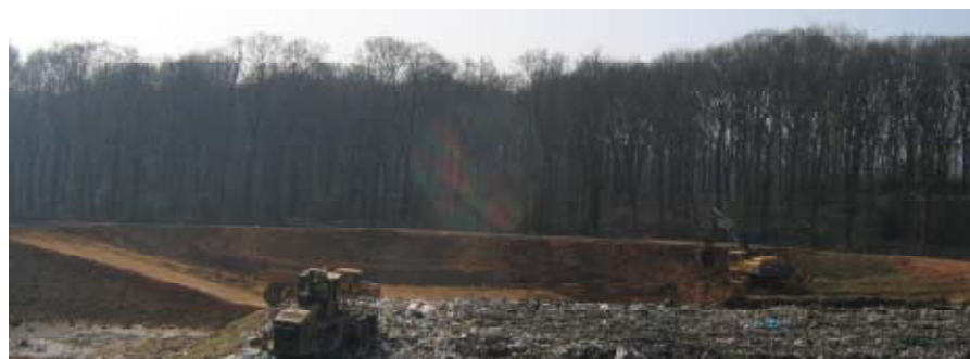
Grainville-la-Teinturière : construction d'une alvéole
